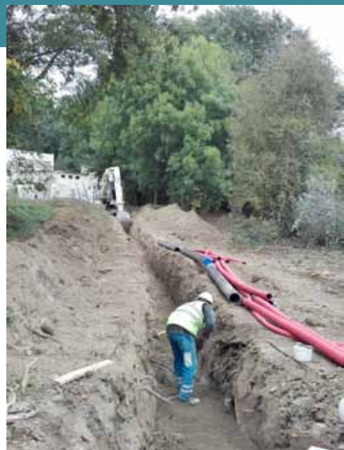
Travaux de liaison puits/station
