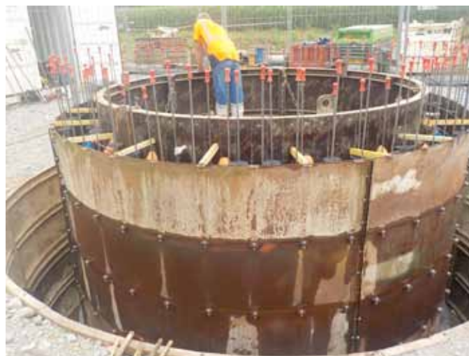
Puits à barbacanes
